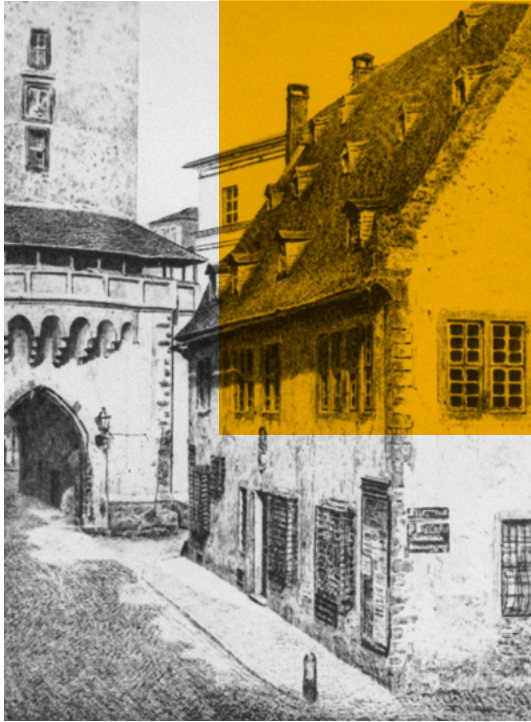
Altes Stiftshaus am Eschenheimer Tor (vor dem Abriss 1866)
